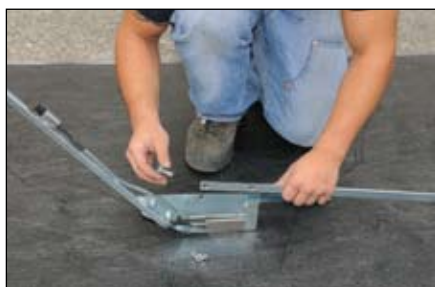
2. Accrocher le rouleau de compression avec manche latéral au chalumeau et le fixer avec un boulon et un écrou à papillon
