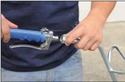
1. Visser le manche au dispositif de recouvrement
