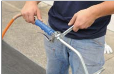
2. Serrer l'écrou du chalumeau avec la clé de 22 mm
