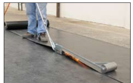
3. Après avoir allumé le chalumeau, mettre le sabot de recouvrement au-dessous de la deuxième membrane en chauffant et en tirant vers soi
